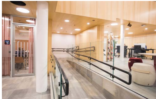
RAMPEADKOMST: En halv etasje ned fra service-senteret til Folkeforumet kan løses ved å ta rampe eller heis. (Foto: Fredrik Naumann/Felix Features).
