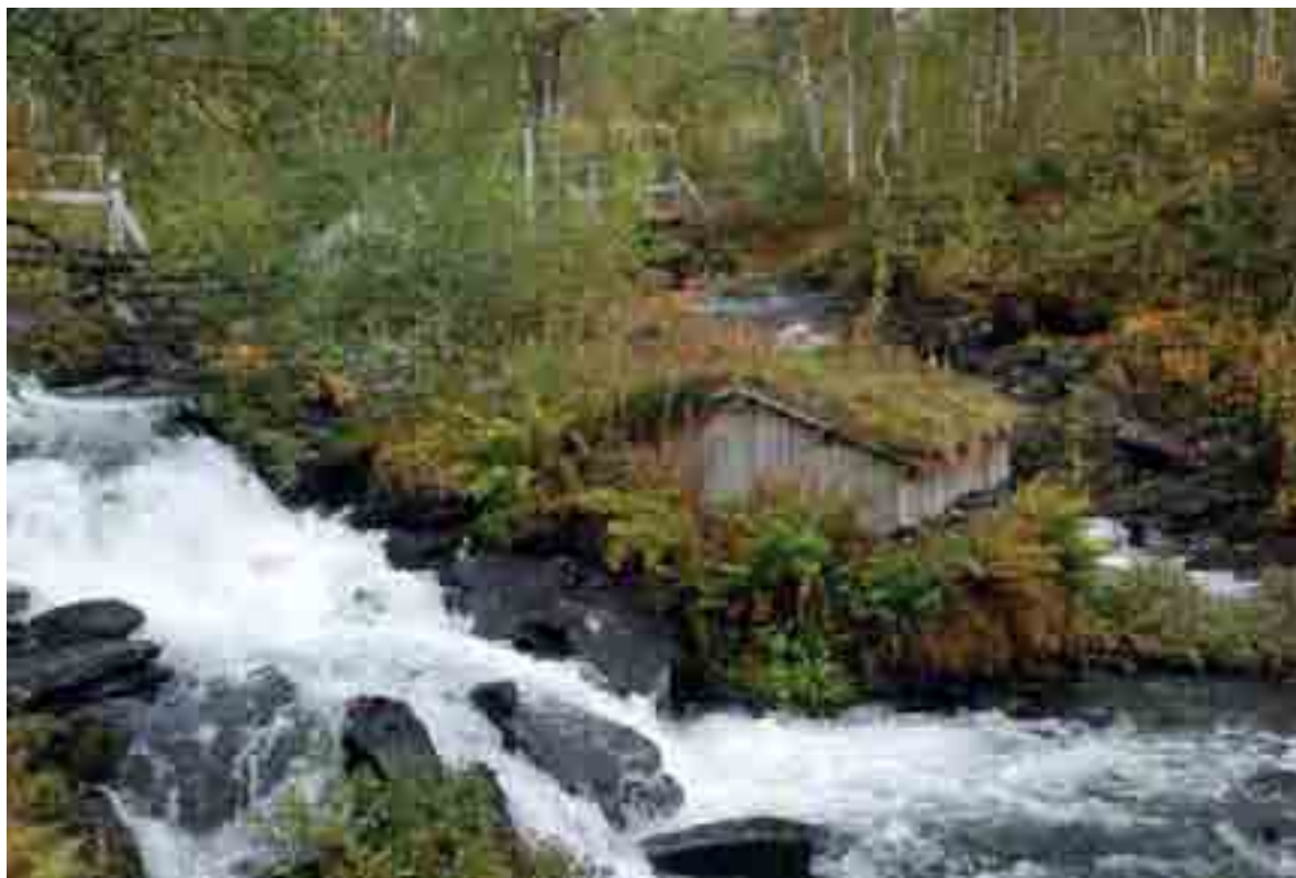
Klekkeriet ved Halsvatn / Hømmervatn Bygd i midten av 30-årene av Edvin Neverhaug og Petter Andersen. Restaurert i 1992 av Øvre Valnesfjord grunneierlag. Foto: Inger Sjøberg.
